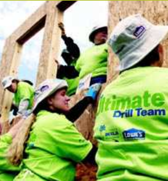
Mujeres voluntarias de Women Build ayudan a construir una pared en Detroit, MI
